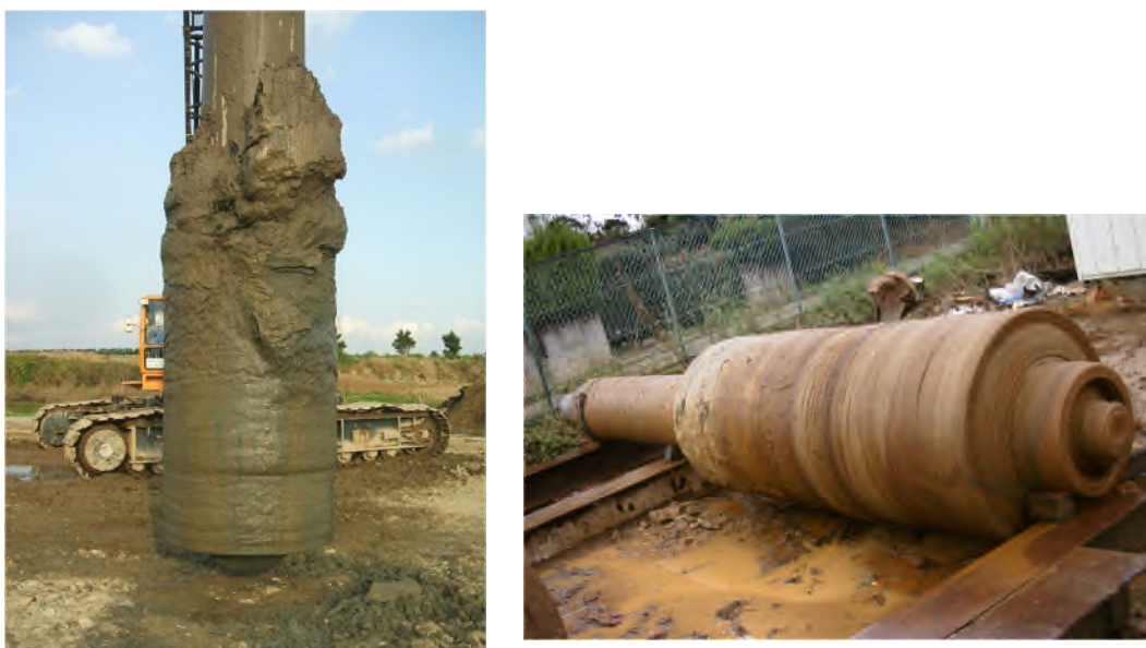
写真 2.1 掘出後の根固め部固化体
