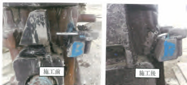
写真 2.13 拡大確認用シェアピンの例 2.17)
