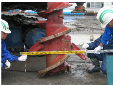
写真 1.4 開翼状態の寸法確認
