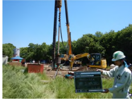
(b) 掘削状況
