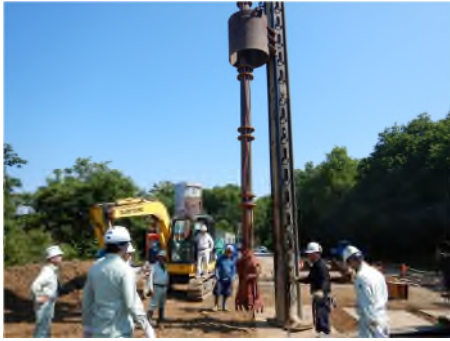
(a) 油圧式拡大掘削ヘッド+掘削ロッド
