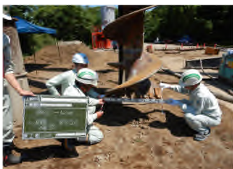
(e) 掘削ヘッド径測定
