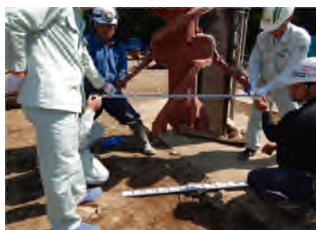
(f) 拡大掘削ヘッド径測定
