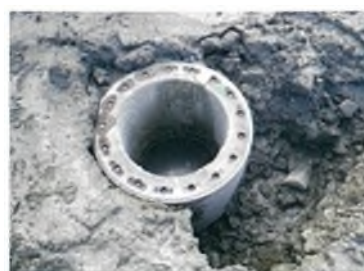
(a) 杭頭露出部分
