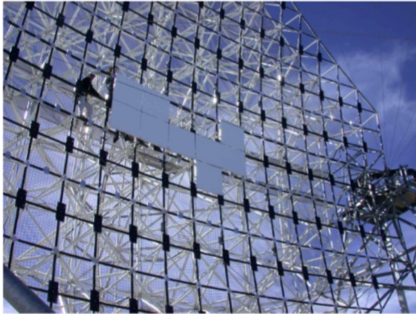
図 4.8 MAGIC-II 望遠鏡の回転放物面構造
