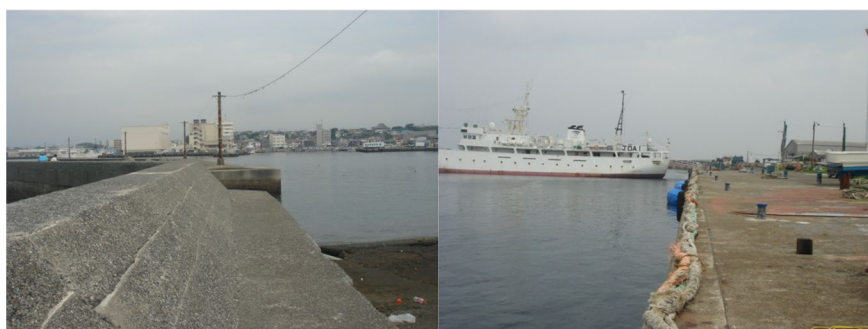
図3-4 西山防波堤(左), 城ヶ崎4号係船岸壁(右)
