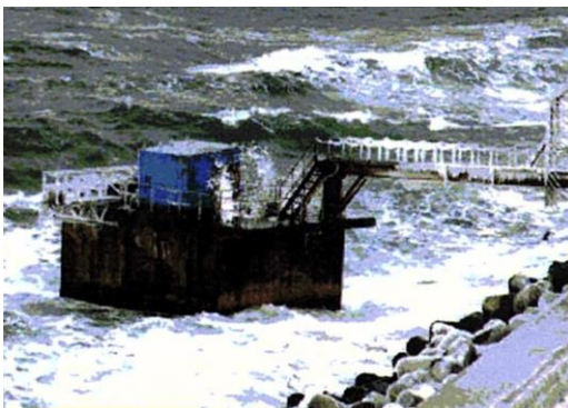
写真 2-9 振り子式波力発電装置 (波力発電 : パワー社)
