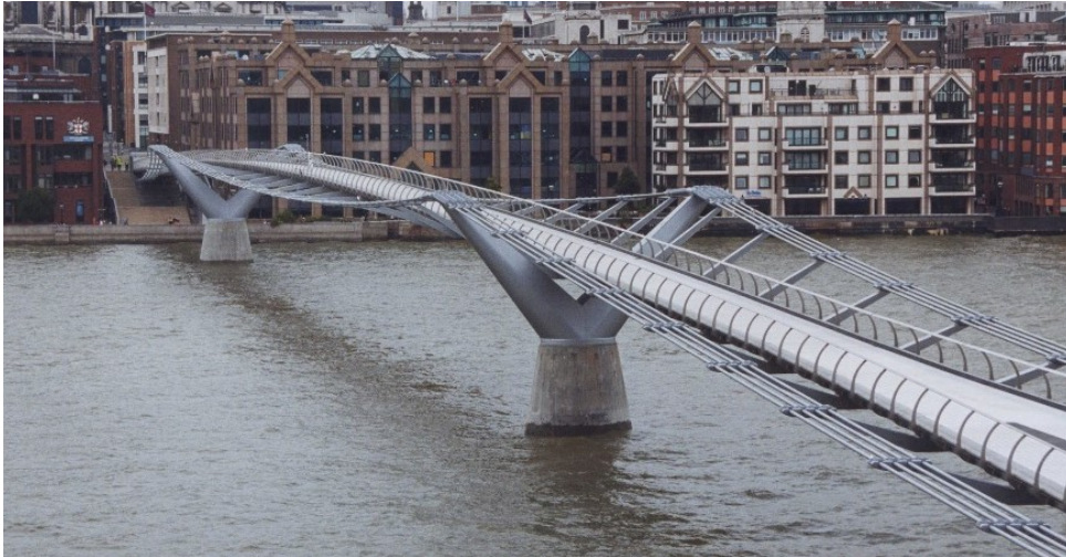
写真-1.1.12 Millennium Bridge (2000 年完成, ロンドン)
