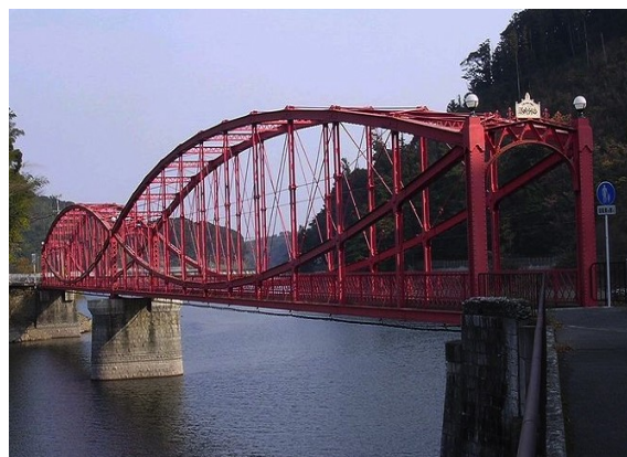
写真-1.2.7 ダブルアーチ
