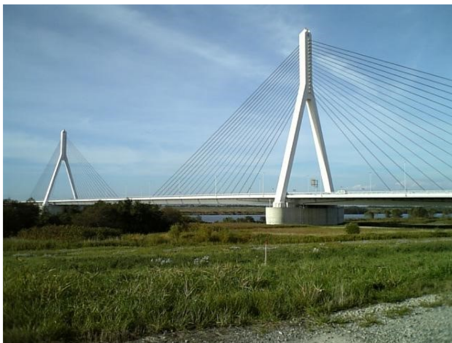
写真-1.1.4 美原大橋 (2005 年完成, 北海道)
