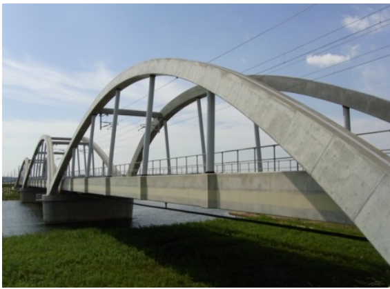
写真-1.2.5 連続下路アーチ
