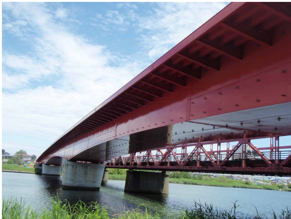
写真-1.1.1 湊大橋（2011 年完成，茨城県）
