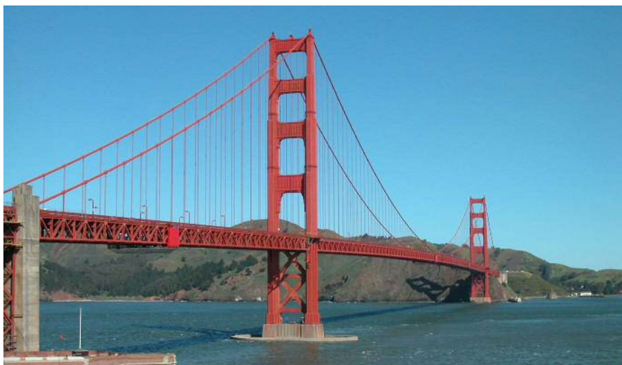
写真-1.1.5 Golden Gate Bridge (1937 年完成, サンフランシスコ)
