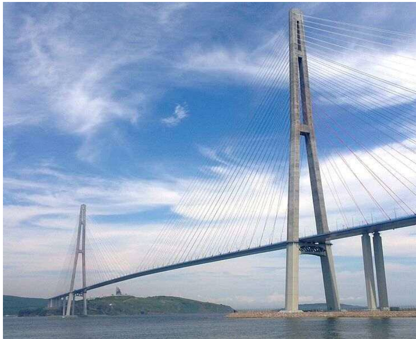
写真-1.1.15 Russky Bridge (2012 年完成, Russia)
