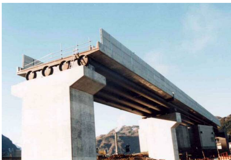
写真-1.2.6 北陸道架道橋（新潟県、CFT 複合桁橋）
