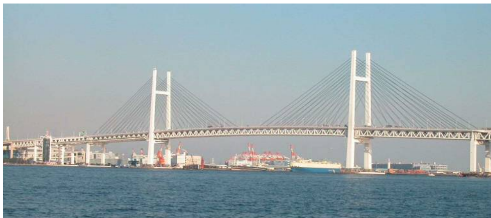
写真-1.1.10 横浜ベイブリッジ（1989 年完成）
