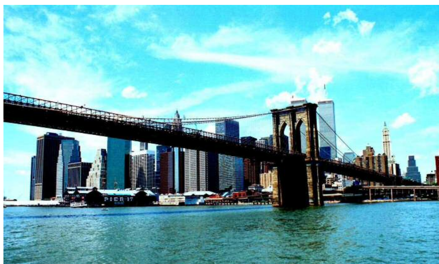
写真-1.1.4 Brooklyn Bridge (1883年完成, New York City)
