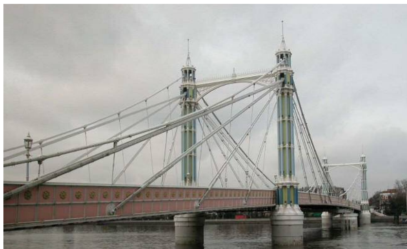
写真-1.1.11 Albert Bridge（1873 年完成, ロンドン）
