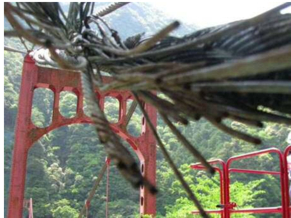
写真-1.2.11 吊橋ケーブル定着部の腐食ケーブル
