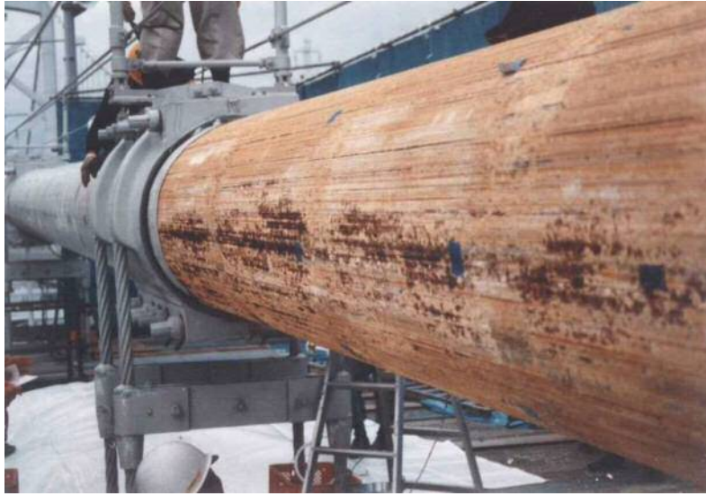
写真-1.2.10 因島大橋ケーブルの腐食
