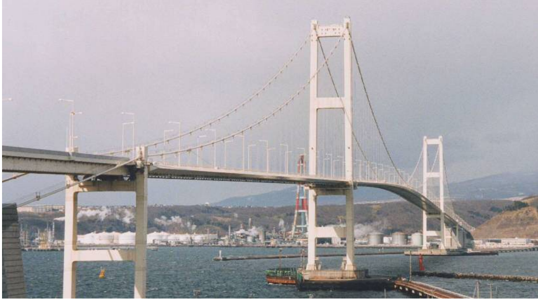
写真-1.1.8 白鳥大橋 (1998 年完成)
