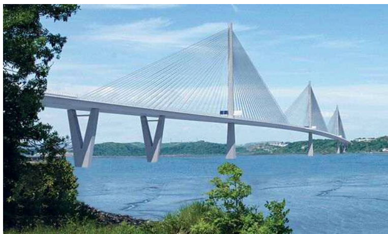
写真-1.2.3 New Forth Bridge (建設中, 英国)
