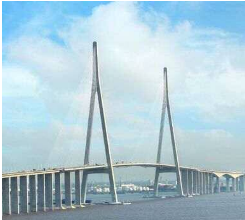
写真-1.1.13 蘇通大橋（2008年完成，上海）
