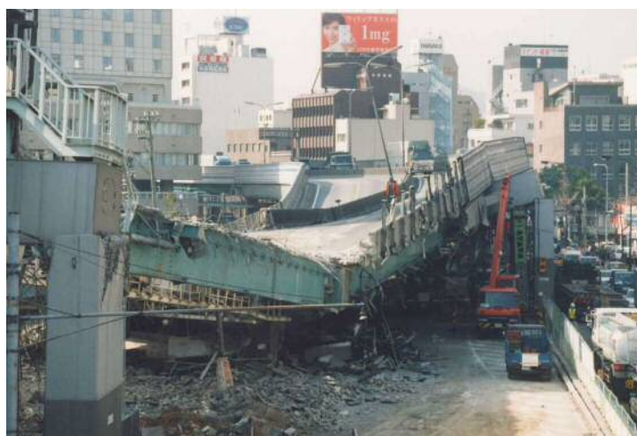
写真-1.2.13 神戸大地震により崩壊した鋼桁
