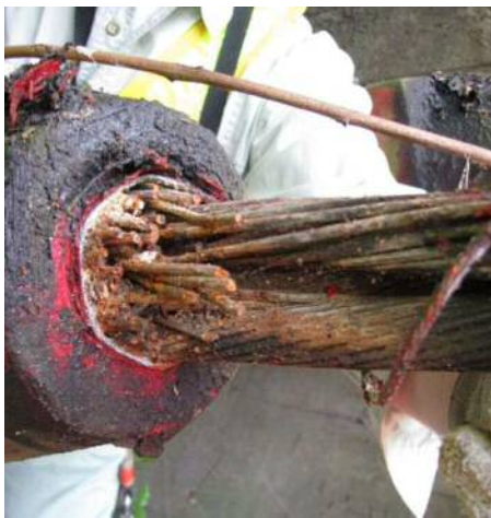
写真-1.2.11 吊橋ケーブル定着部の腐食ケーブル
