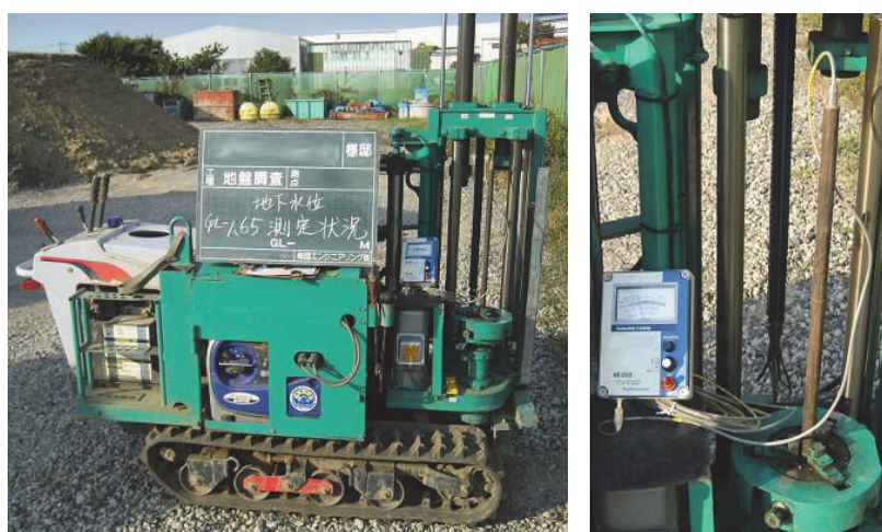
写真 3. 2. 1 SWS 試験直後の SWS 試験機での地下水位測定状況
