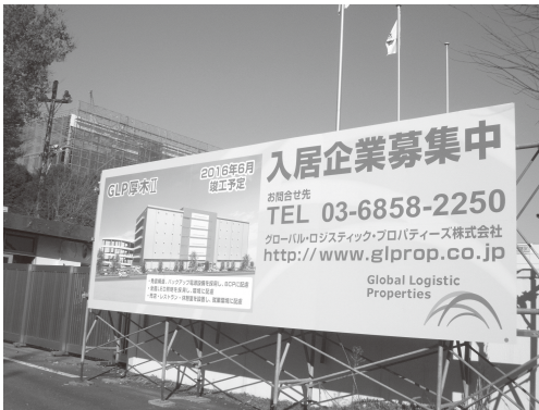
図8 内陸工業団地内に建設中の GLP 厚木Ⅱ
