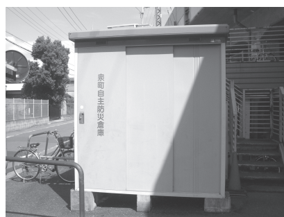
図 2-4 厚木市内の自主防災倉庫
