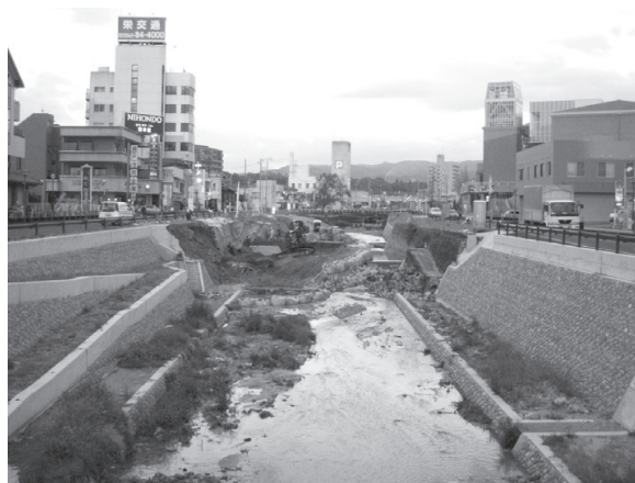
図6 拡幅工事中の瀬戸川と右端の瀬戸蔵
